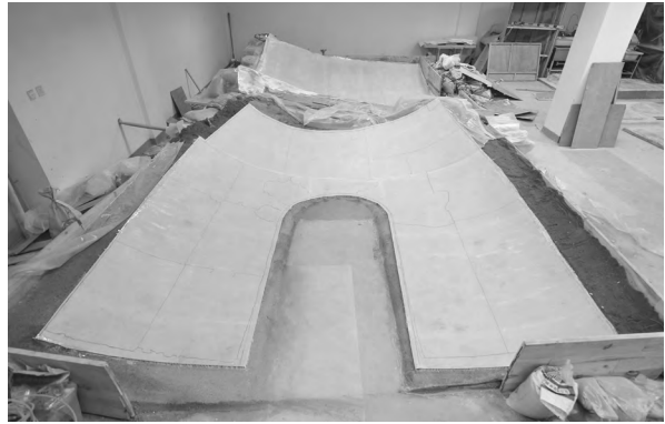
图四 制作好的南壁异形支撑体
