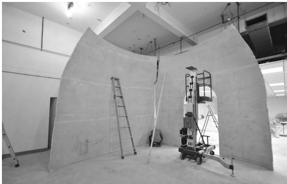
图五 组装相邻壁面支撑体
